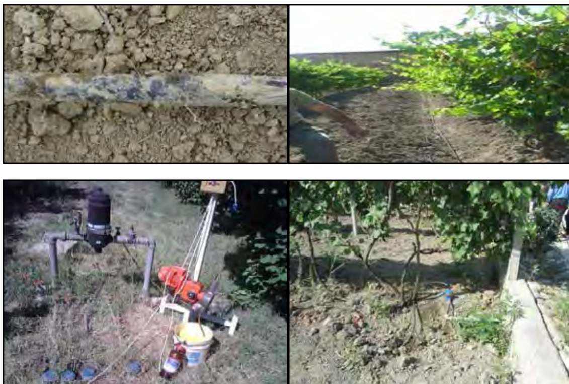
نمونه‌ای از گرفتگی قطره چکان‌ها توسط ریشه و نحوه تزریق ترفلان به سیستم آبیاری
