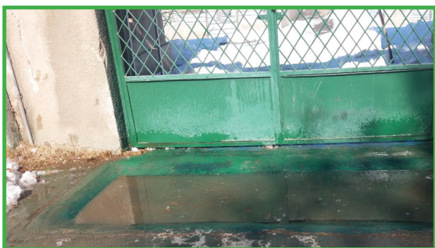
شکل ۴۵- حوضچه ضدعفونی جلوی در ورودی
