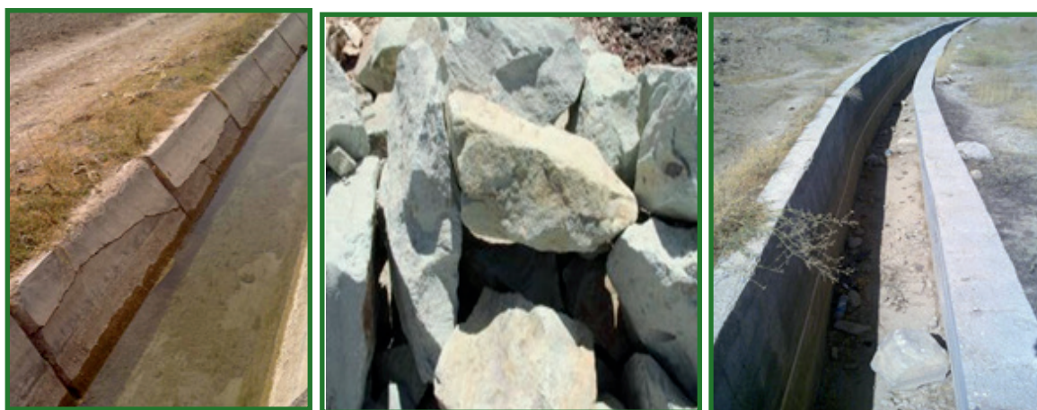
پوشش سنگ و ملات با رویه سیمانی سالم (سمت راست)، سنگ لاشه مصرفی (وسط) و پوشش بتنی تخریب شده (سمت چپ)
