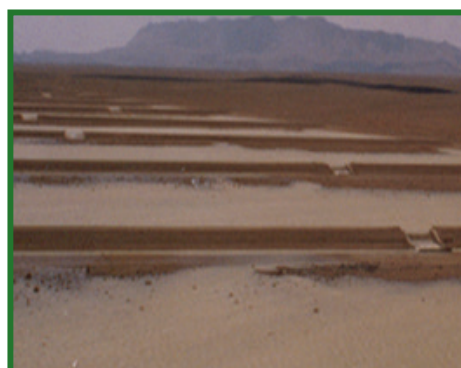
خاکریزها، دروازه‌ها و عرصه‌های پخش سیلاب باغ سرخ حوضچه‌های تغذیه‌ی مصنوعی سد کردکوی پس از مهار سیل
