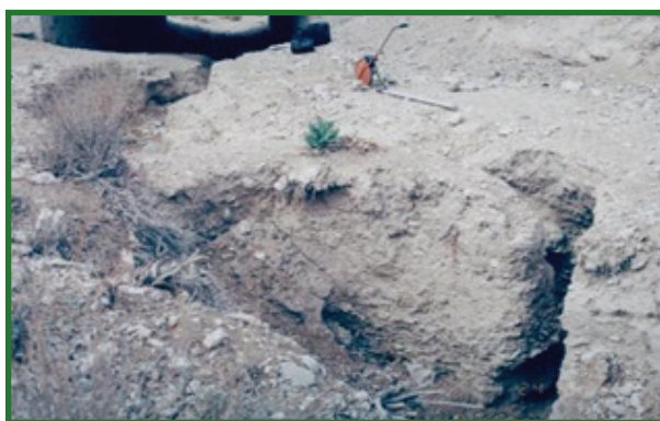
خندق ایجاد شده در اثر انتقال آب چند منطقه از زیر یک پل
