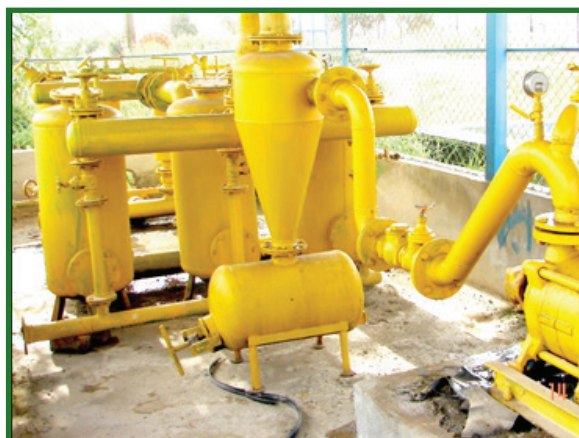
شکل ۱- سیستم کنترل مرکزی پروژه آبیاری قطره ای
