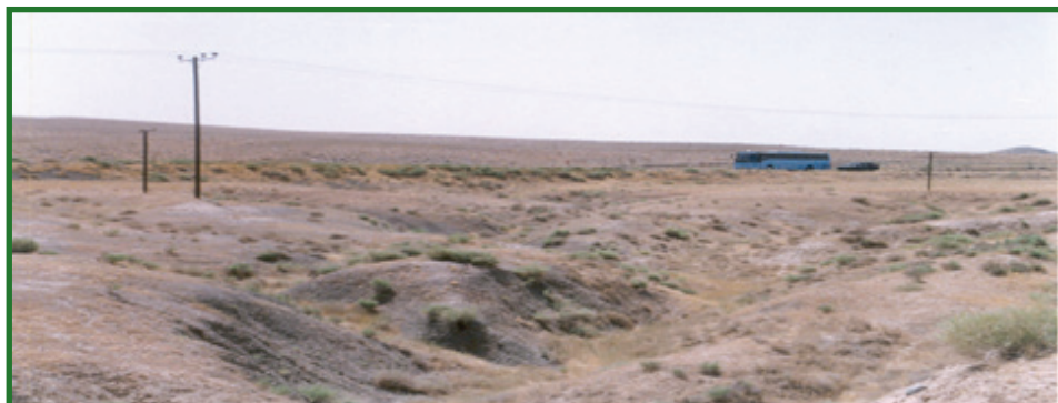
شکل ۲- تشکیل خندق در کنار آبگذرهای جاده‌ای در منطقه راهجرد
